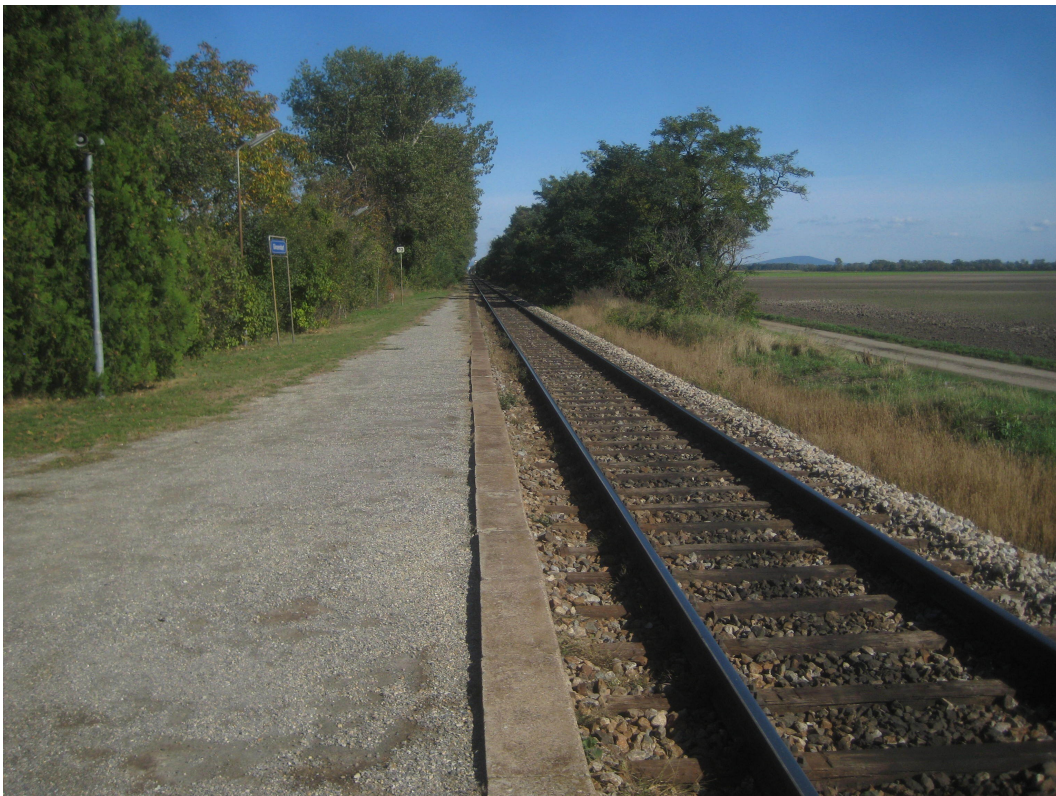
Abb. 07: Die Hauptstrecke (!) zwischen Wien Hbf und Bratislava Hbf bis vor kurzem (Foto aus dem Jahr 2008, Bahnhof Glinzendorf): eingleisig und nicht elektrifiziert
